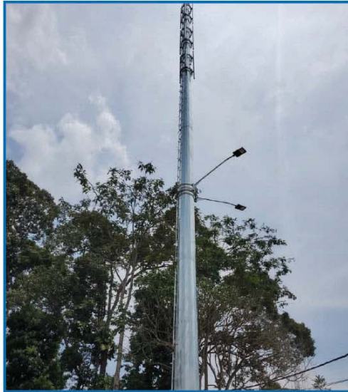
Monopole Pengkalan Hulu, Perak
